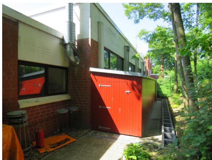
2014 förderte der Förderverein den Anbau eines Carports für die Materialunterbringung an der Feuer- und Rettungswache.
